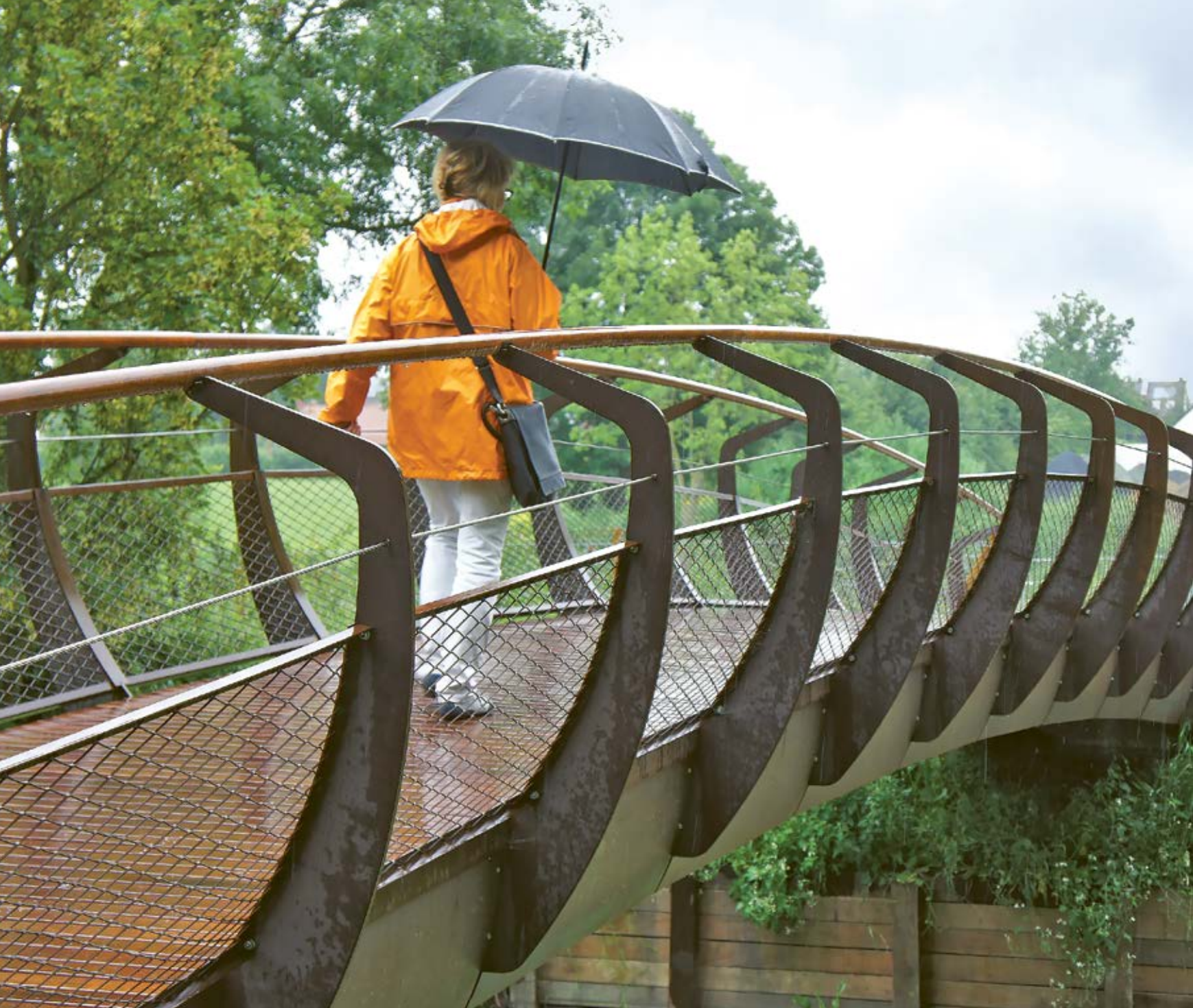
Une Passerelle Swan d'une portée de 18 mètres en acier CorTen a été installée dans une zone naturelle située en bordure du canal du Jard à Vieux-Condé (France). Ce projet a été réalisé en collaboration avec Atelier Nervures et IdVerde Agence de Bouchain.
