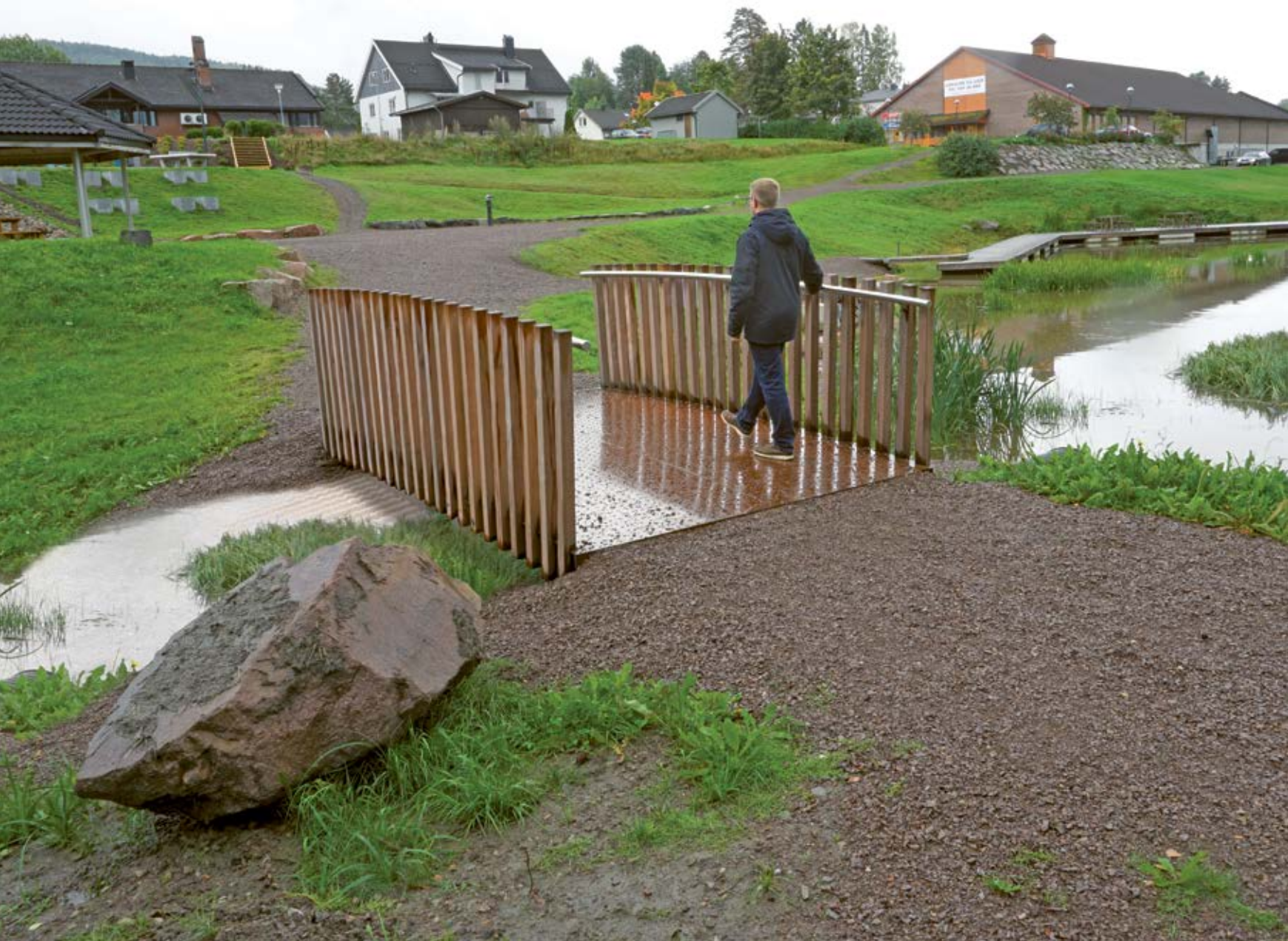
Une Passerelle Solo a été installée à Hvittingfoss (Norvège) avec une main-courante en bois dur FSC associé au revêtement Cordeck® doté de 'dots' (pastilles en relief) pour une meilleure adhérence.
