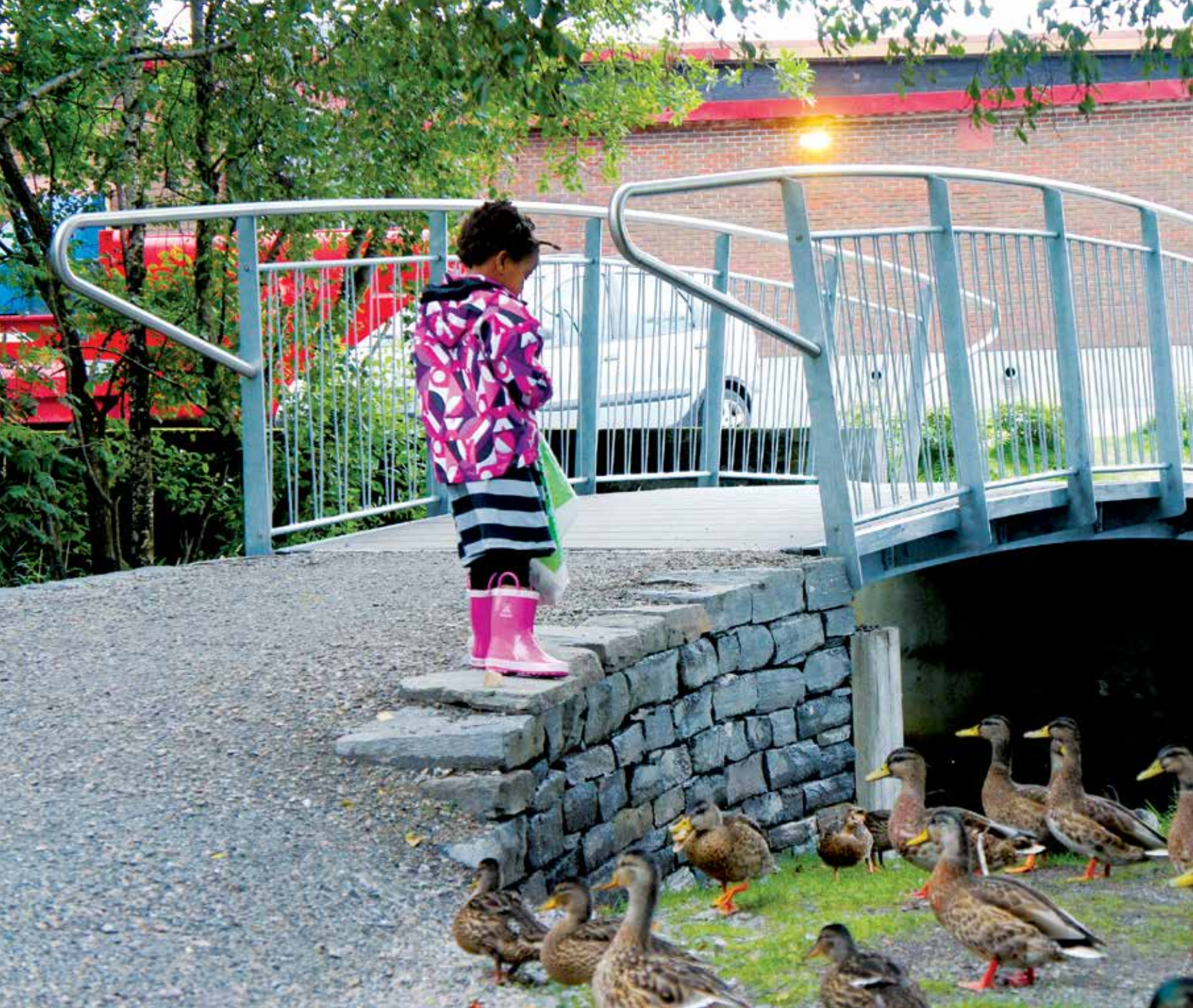
Diese Shortline Brücke mit ZigZag Geländer wurde in Bergen (NO) realisiert als Zugang zum Park. Ein Brückenkopf wurde zusätzlich erhöht, für einen subtilen Übergang.
