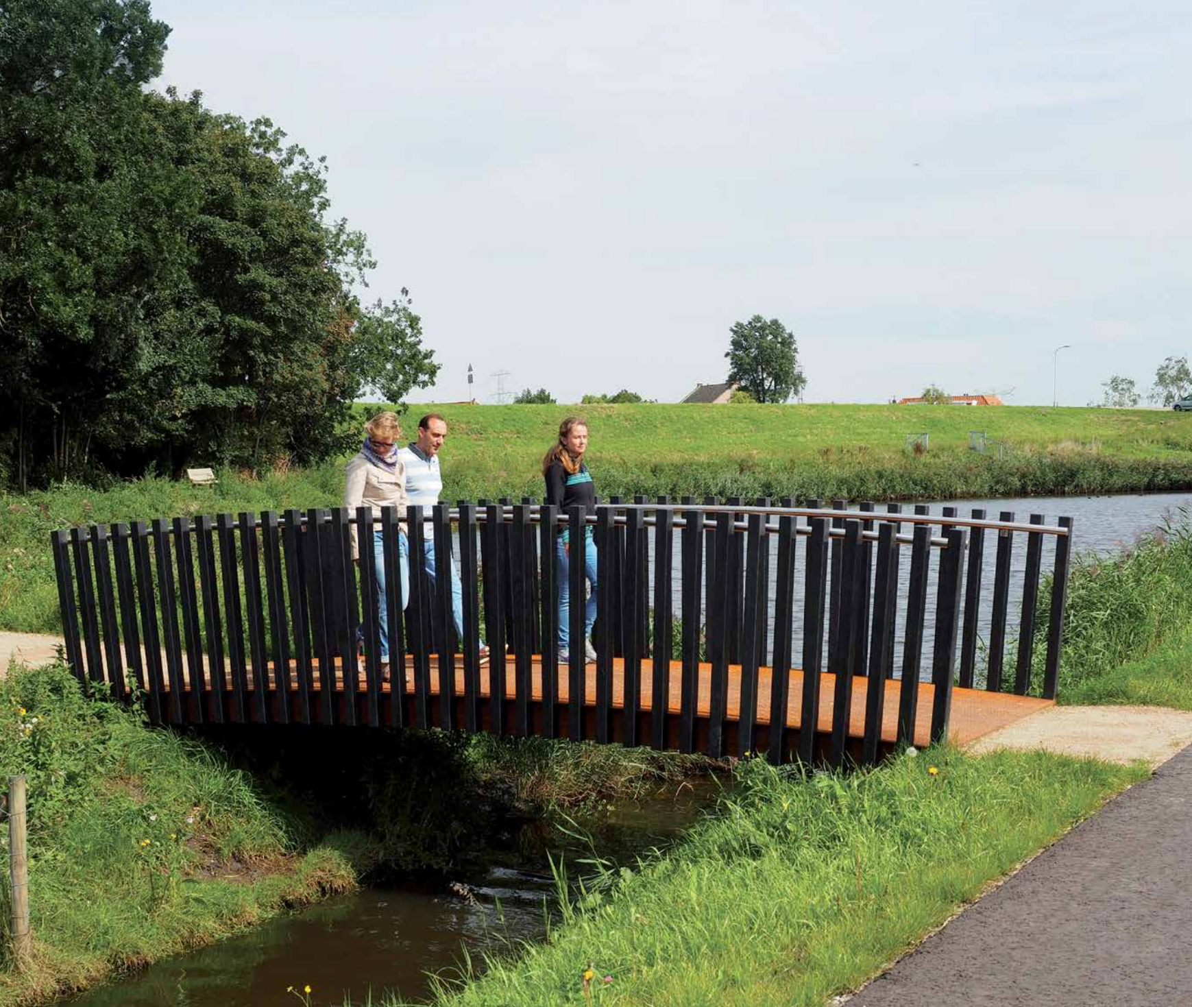
Bij deze duurzame Solo Brug is de gehele draag- en dekconstructie uit een dikwandig CorTen staalplaat gemaakt. De spijlen van het hekwerk zijn van All Black composiet. Het warmbruine dek is voorzien van een patroon van CorTen anti-slip nokjes.
