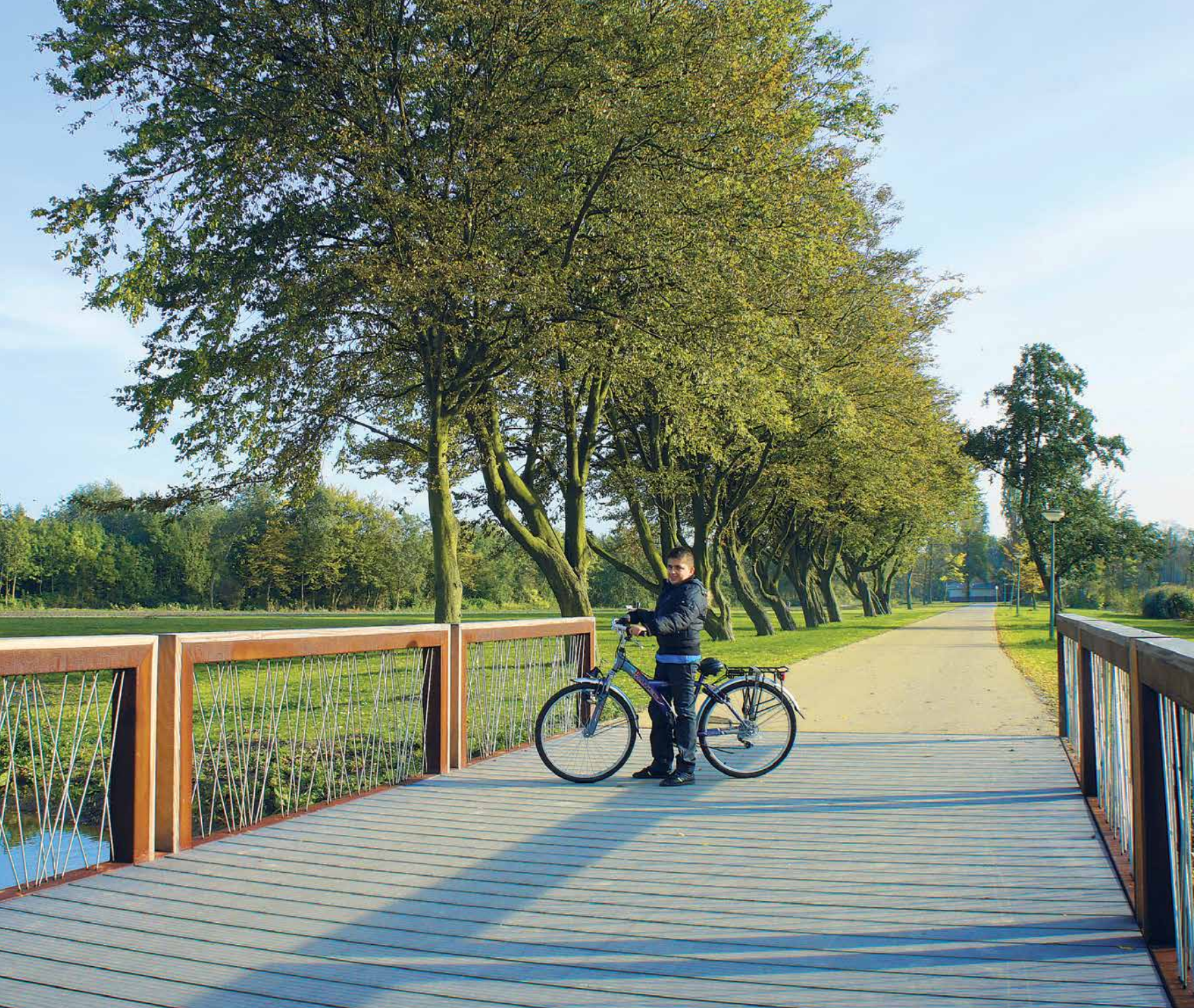
Deze schitterende Crossline CorTen Brug vindt u in het Park 't Nieuwelant te Vlaardingen (NL). De robuuste CorTen balusters met wilde spijlen harmoniëren fraai met de meerstammige bomenrij!
